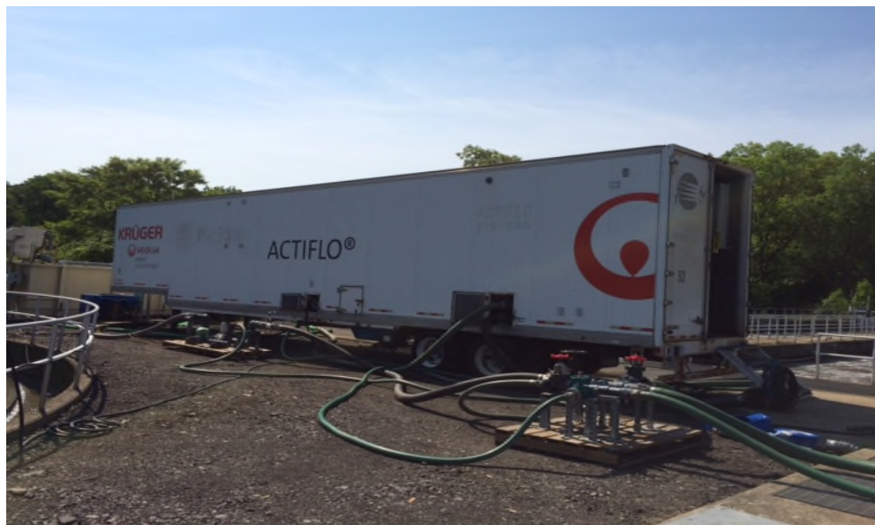
Figure 4.1: ACTIFLO®/BIOACTIFLO® Process Setup
